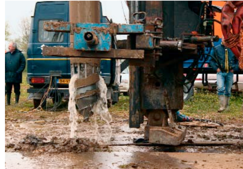
8.2 • Voorbeeld van een innovatieve techniek, een praktijkproef uiterwaardverlaging bij Everdingen met behulp van een zuiglans (foto's Gertjan Geerling).
