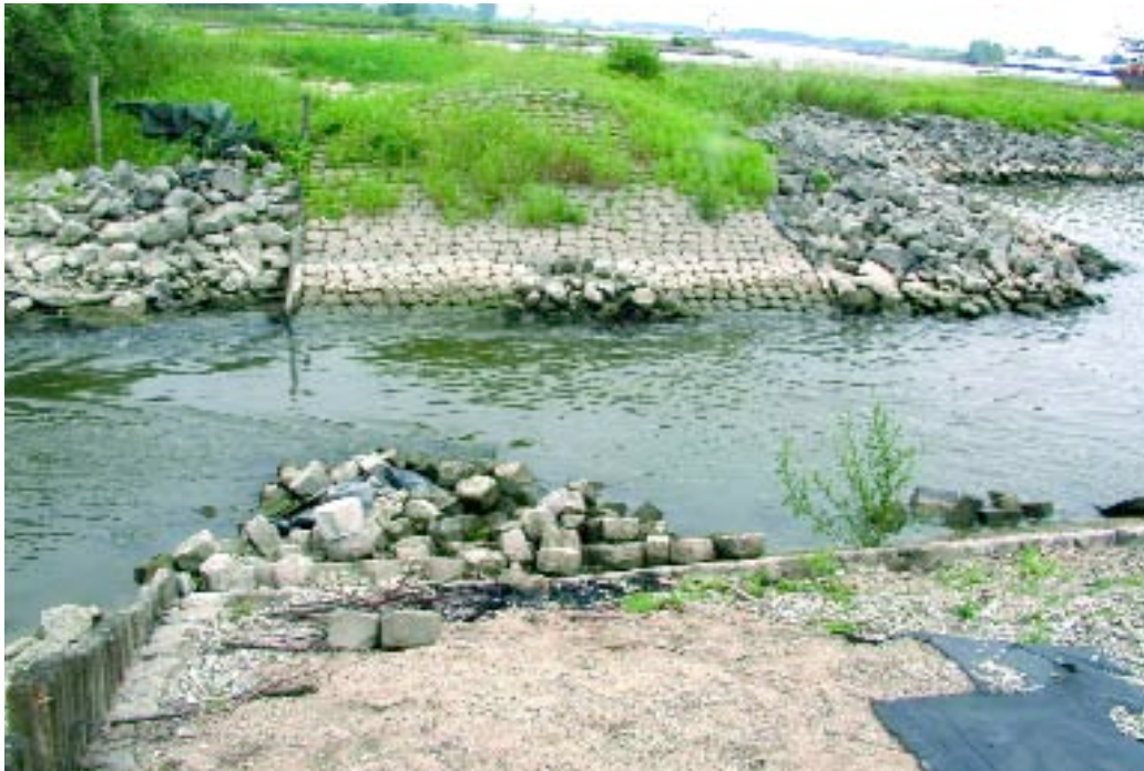
6.3 • Twee buizen onder een werkweg vormen de gecontroleerde inlaat voor de nevengeul van Beneden-Leeuwen (foto Rijkswaterstaat).
