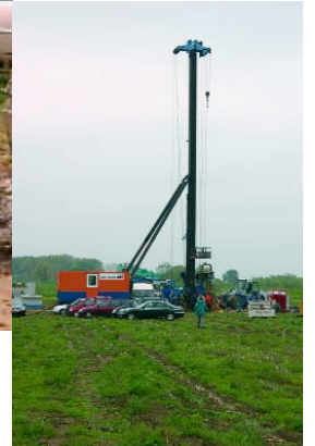
8.2 • Voorbeeld van een innovatieve techniek, een praktijkproef uiterwaardverlaging bij Everdingen met behulp van een zuiglans (foto's Gertjan Geerling).
