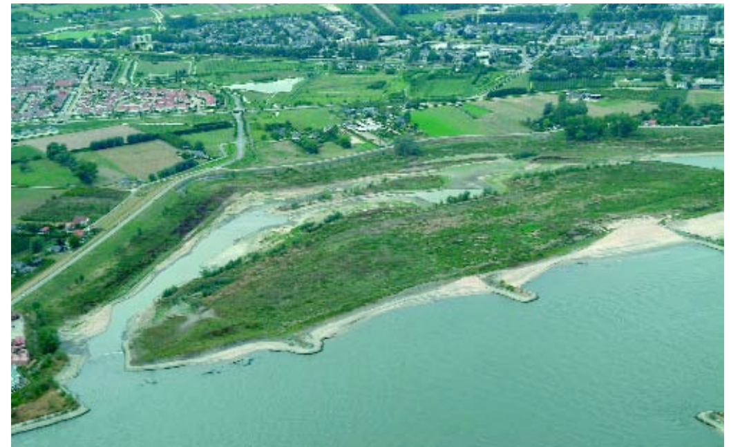
5.5 • Nevengeul in de Passewaay bij Tiel tijdens laagwater in 2003 (foto Rijkswaterstaat).
